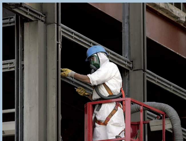
Bild 5 Entfernung von Spritzasbest als Brandschutzmasse vor dem Rückbau des Palastes der Republik Berlin [C.2]
