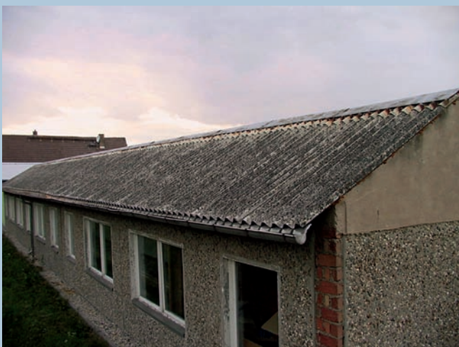
Bild 2 Dachdeckung aus Wellasbestzement [C.1]
