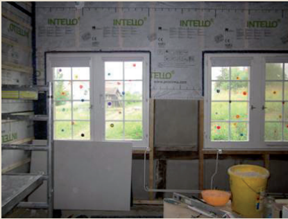
125 | Baustellensituation bei der Umsetzung der Innendämmung
