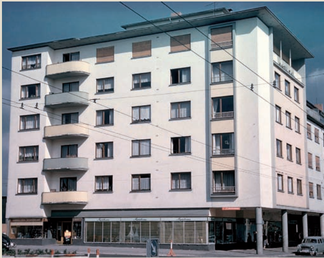
59 bis 60 | „Haus Mohr“, Eisenbahnstraße, 1958 und 2013
