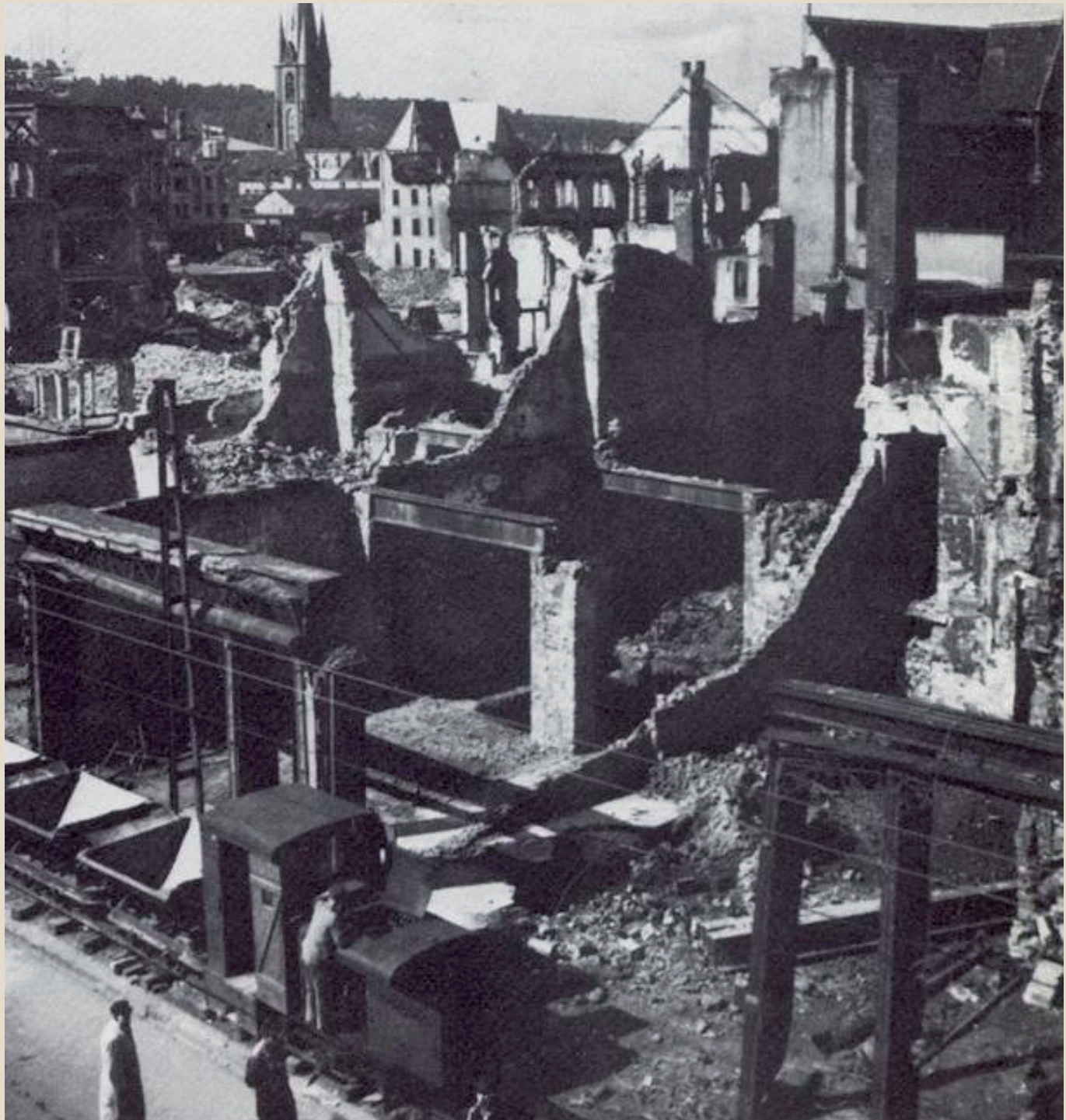
15 | Eisenbahnstraße, Trümmerbe- seitigung, um 1946
