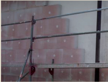
126 | Baustellensituation bei der Umsetzung der Außendämmung
