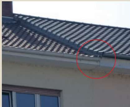
94 | Unsanieret und saniert nebeneinander bei Veränderung der Dachtraufe, nachcoloriert
