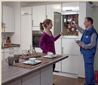
133 | Raumsparender Fernwärmeschluss
