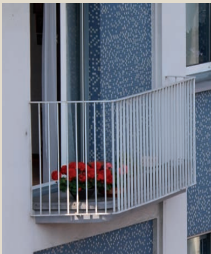
167 | Balkon am Musterhaus in der Eisenbahnstraße
