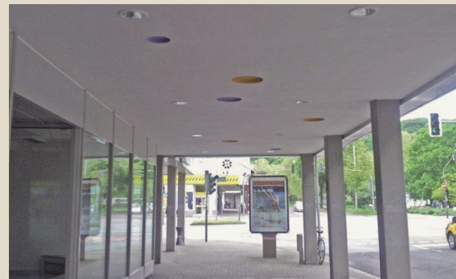
6. Umgesetzte Musterdecke in der Eisenbahnstraße
