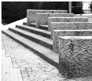
Burbacher Markt, Treppe, 1998, Nr. 27
