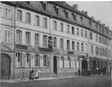
Hotel Kaiserhof, Foto nach dem 1890 erfolgten Einbau einer Eingangstür in die Straßenfassade
