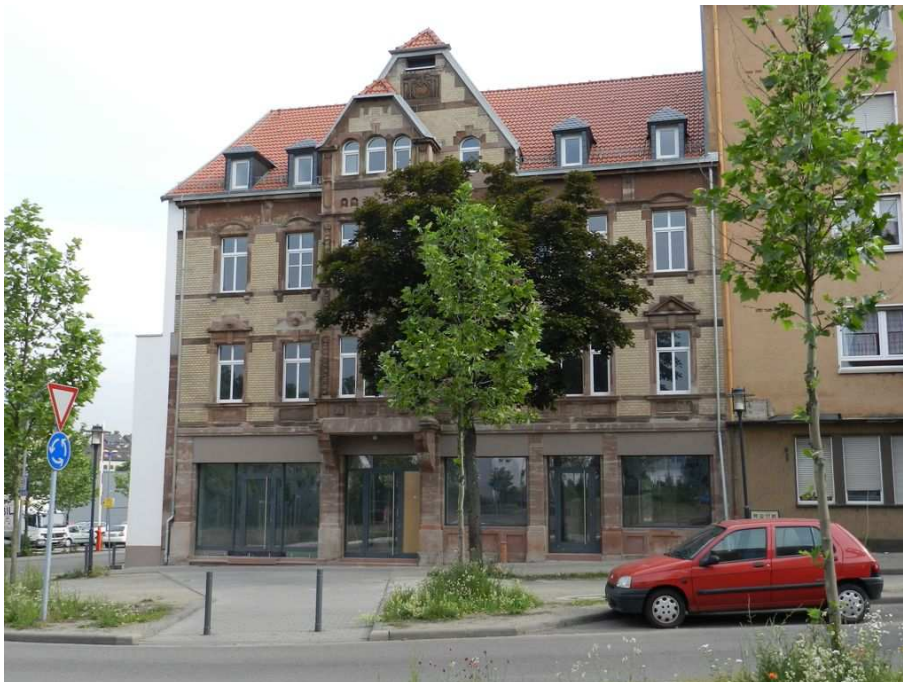
Hochstraße 110 nach Sanierung / Darstellung Landeshauptstadt Saarbrücken
