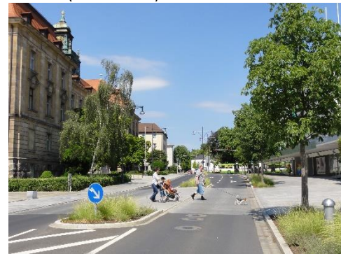
Abbildung 6: Mittelinsel mit Fahrbahnbelagswechsel (Schweinfurt)
