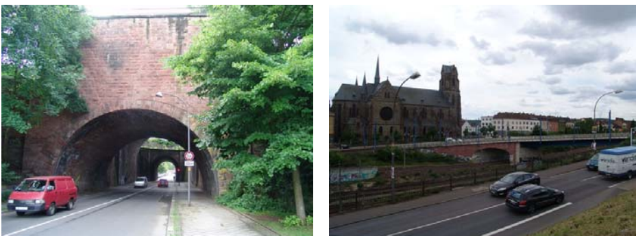
Abb. 10: Südportal Straßentunnel Ludwigsstraße, Kirche St. Josef 27
