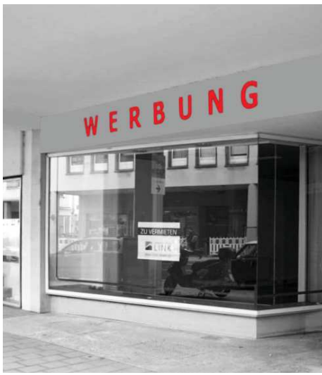
Werbeanlage oberhalb des Schaufensters
