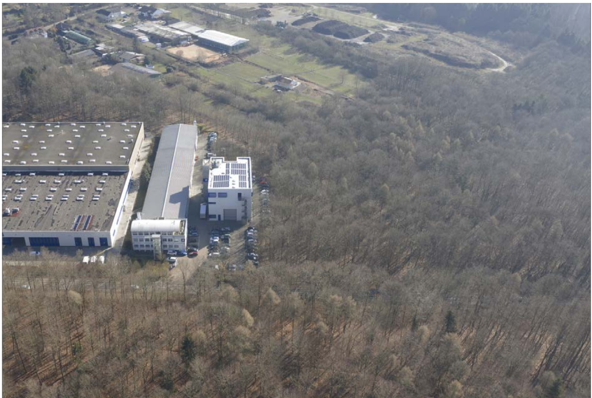
Blick von Westen auf die Erweiterungsfläche der Fa. Woll Maschinenbau GmbH innerhalb des Plangebietes
