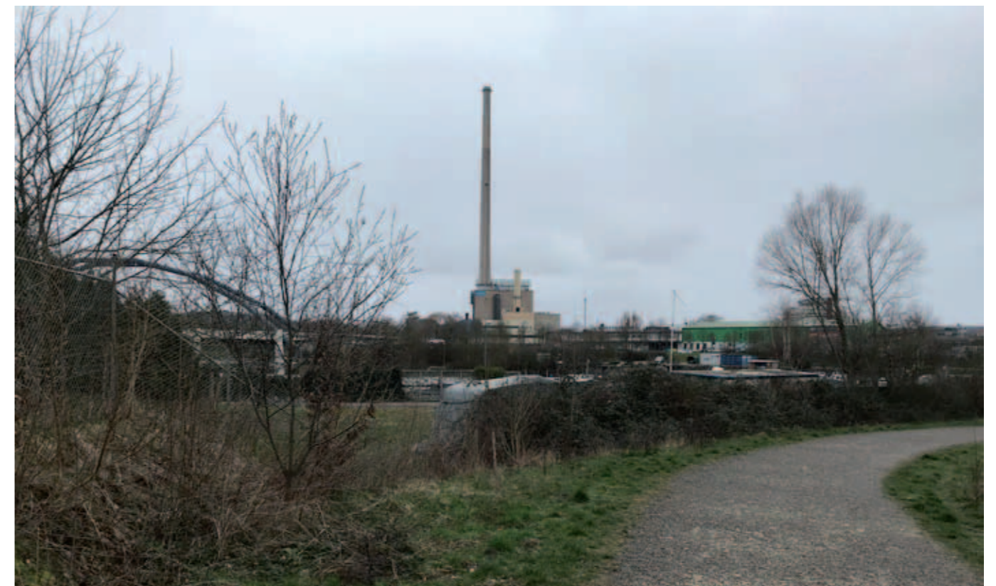
Abb. 56: Heizkraftwerk und Gewerbegebiet an der Ostspange aus Sicht des Osthafens
