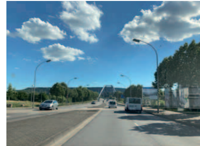
Abb. 19: "Zur Ostspange" mit Blick auf Ostspangenbrücke
