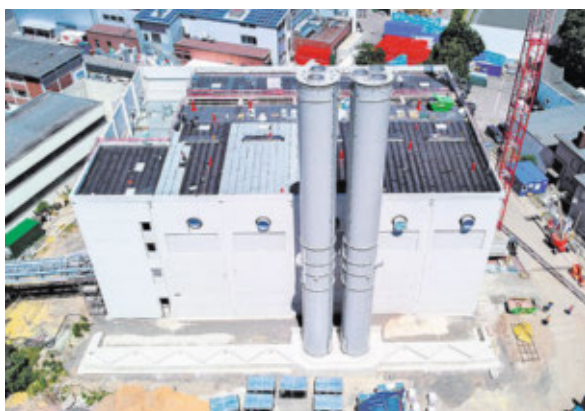
Gasmotorenkraftwerk Römerbrücke im Juni 2021
