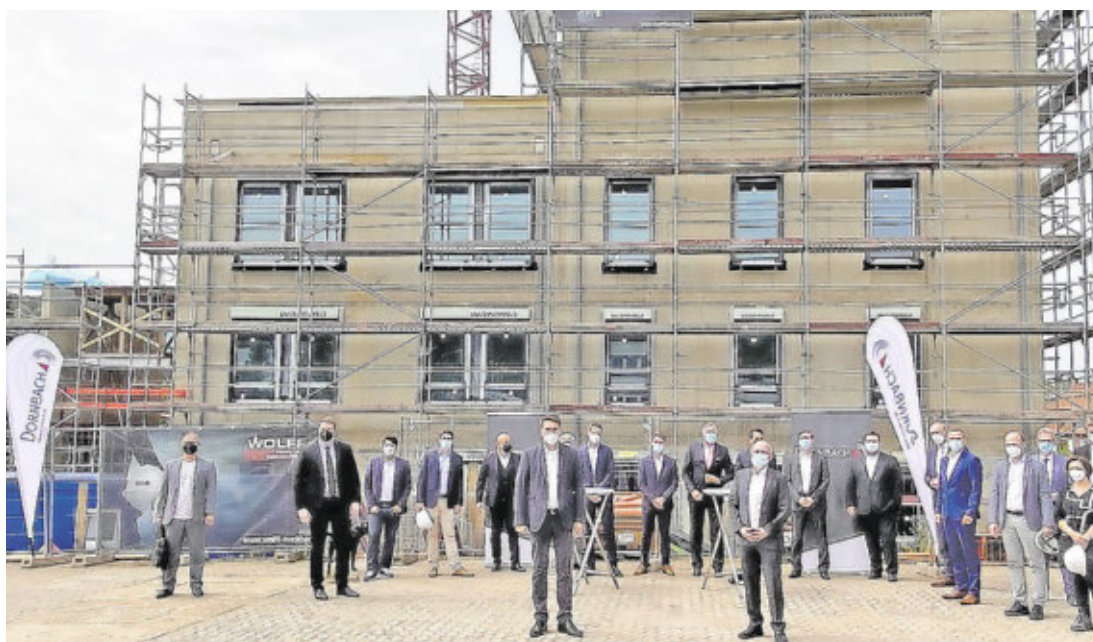
Richtfest beim neuen DORNBACH-Gebäude am Eschberger Weg in Saarbrücken. Foto: DORNBACH GmbH
