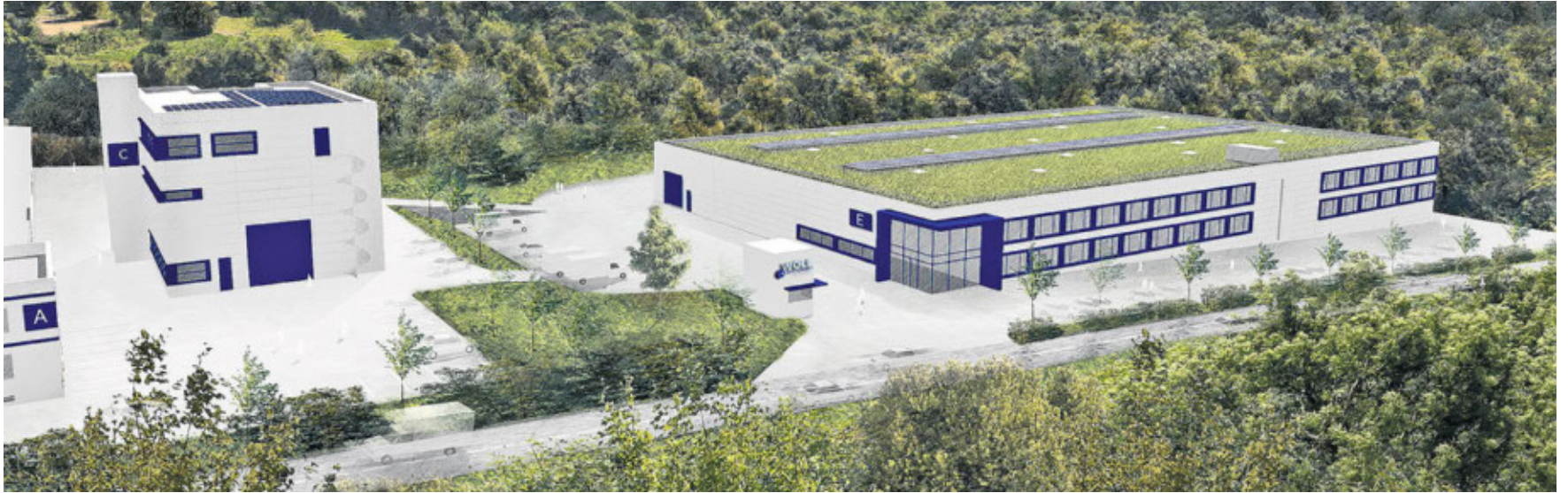
Der Erweiterungsbau am Standort Gersweiler schafft Raum für Anlagen und sichert Arbeitsplätze im Saarland.
