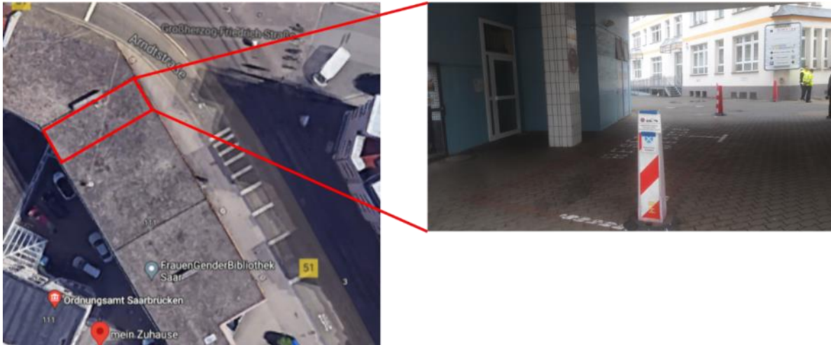
Abbildung 40: Standort Ordnungsamt (Großherzog-Friedrich-Straße)
