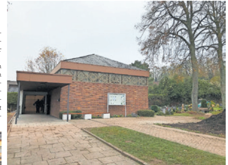
Fassade und Dächer der Einsegnungshalle auf dem Bübinger Friedhof wurden saniert.
