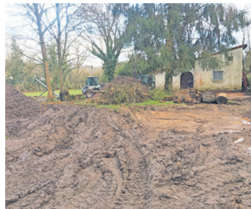
Arbeiten auf dem Gelände des Abenteuerspielplatzes Meiersdell.
