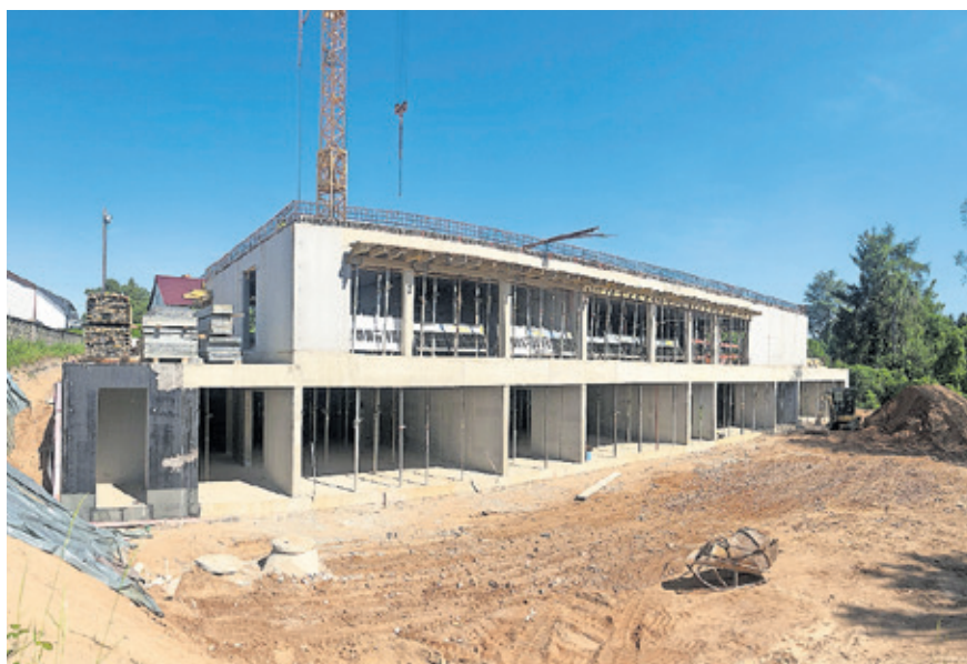
Der Rohbau der Kita Waldwiese in Klarenthal ist fertiggestellt.
