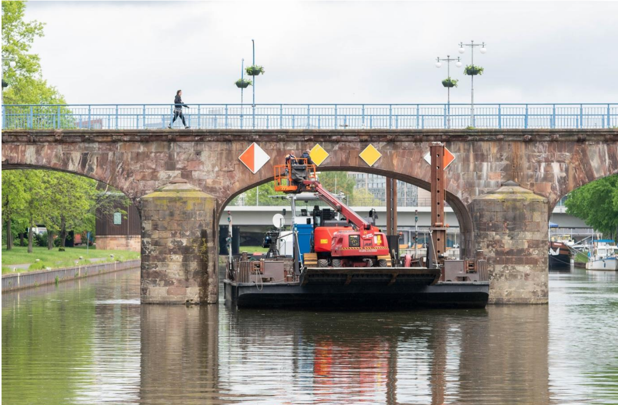
Schadenskartierung. (Foto: Michael Botor)
