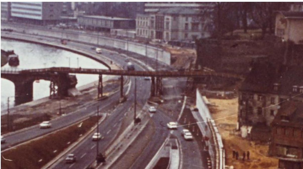
Fußgängersteg (Holzsteg) während des Autobahnbaus. (Privatsammlung Hans Mildnerberger)
