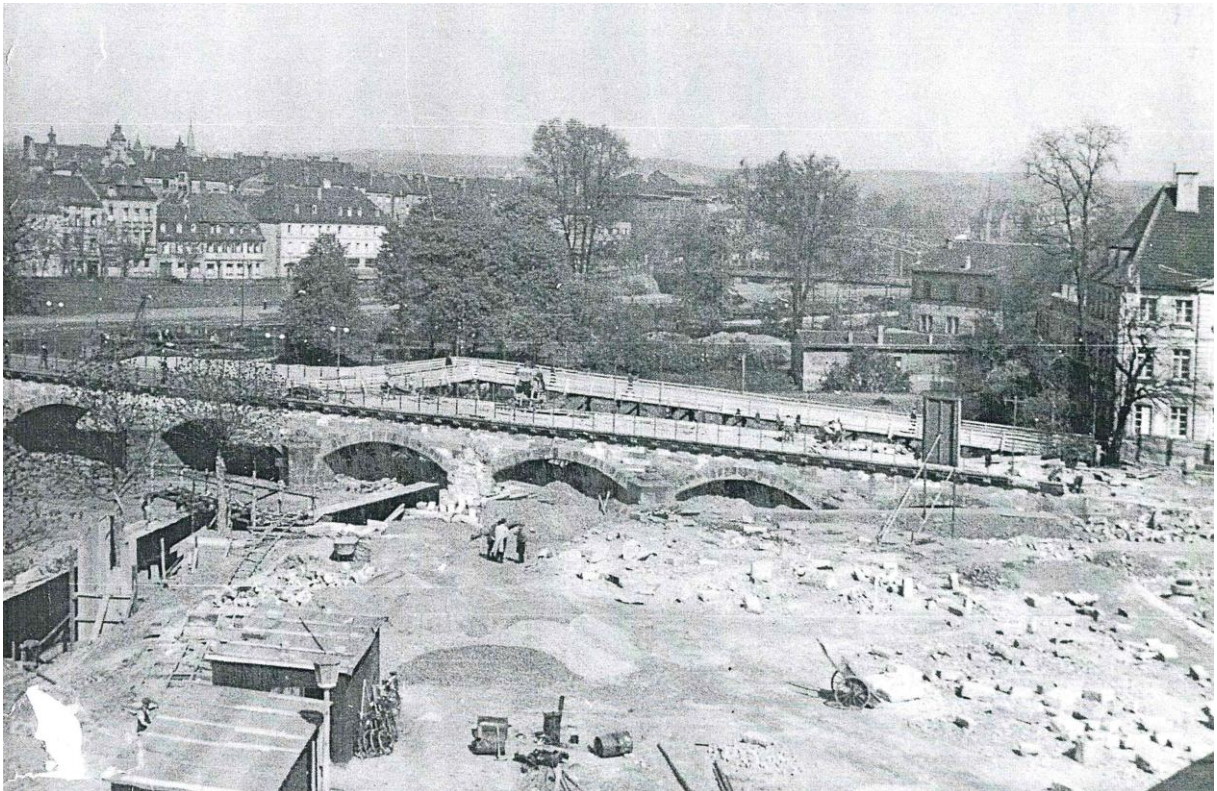
Baustelle Theaterplatz mit den drei letzten noch vorhandenen Bögen vor der Abtragung und Einschüttung.
