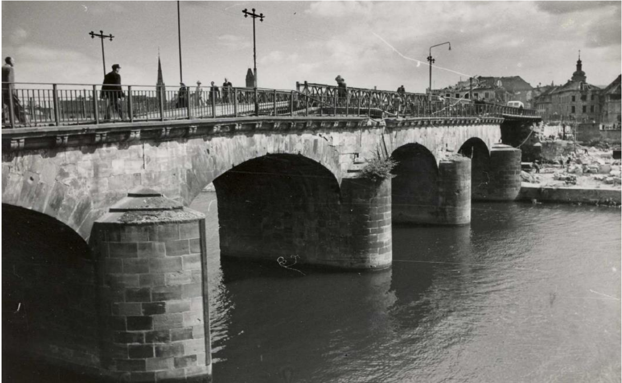
Notbrücke über beschädigten Flussbogen. (Privatsammlung Hans Mildenberger)
