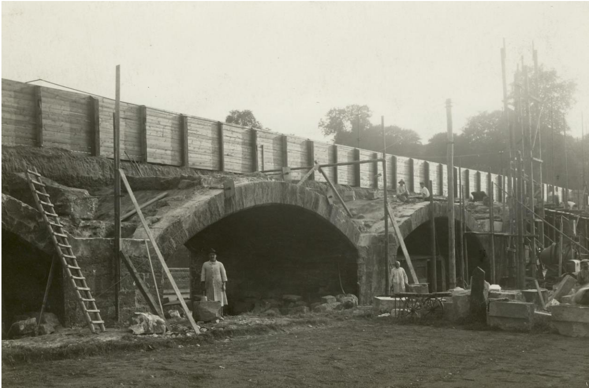
Sanierungsmaßnahmen an den Bögen. (Privatsammlung Hans Mildenerger)
