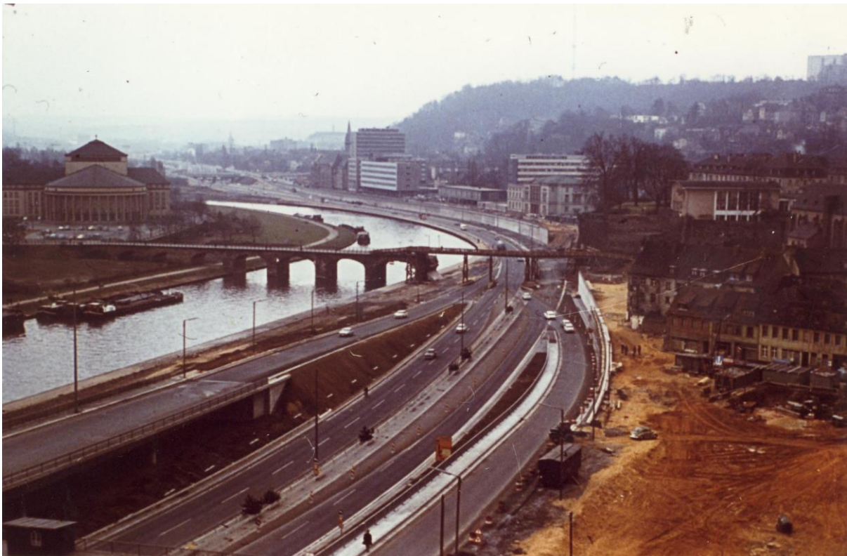
Bau der Autobahn B 406 in Fahrtrichtung St. Arnual 1964. (Privatsammlung Hans Mildnerberger)
