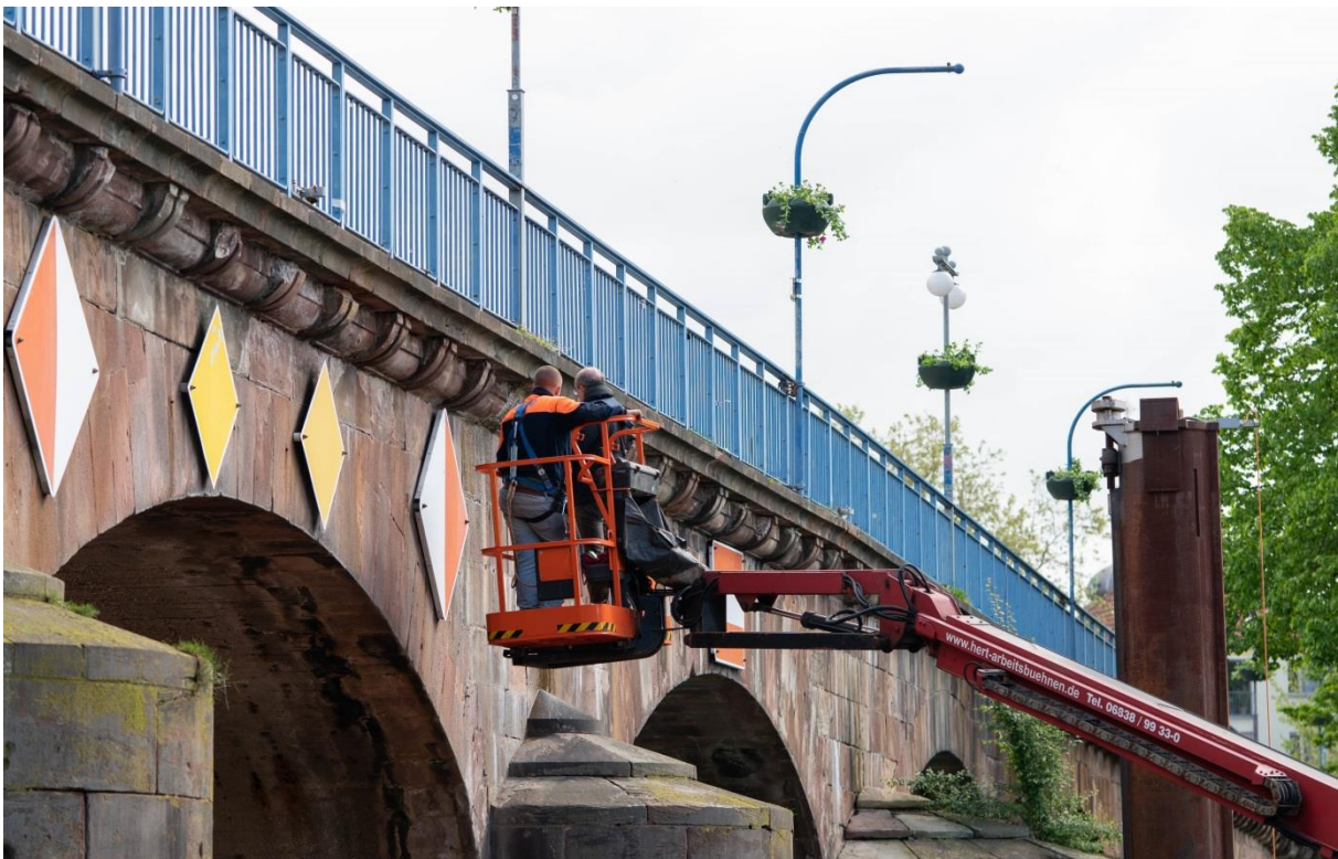
Schadenskartierung. (Foto: Michael Botor)
