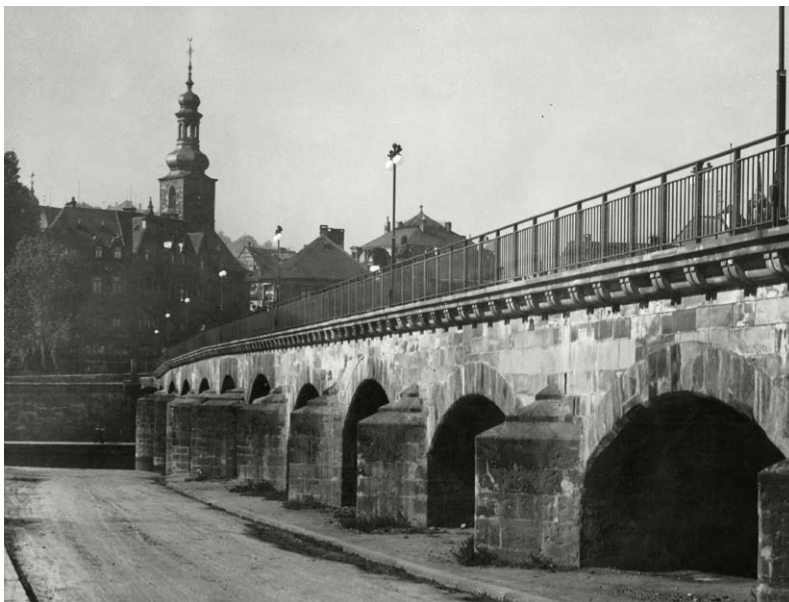
Die Alte Brücke ließ Graf Philipp II. von Nassau-Saarbrücken auf Geheiß Kaiser Karl V. in den Jahren 1546–1548 errichten. Mit ursprünglich 14 Bögen überspannte sie die Saar auf einer Distanz von knapp 170 Metern.
