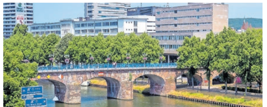
Die Sanierung der Alten Brücke soll das Bauwerk und den umgebenden Stadtbereich weiter aufwerten. Foto: Anika Colbus/LHS
