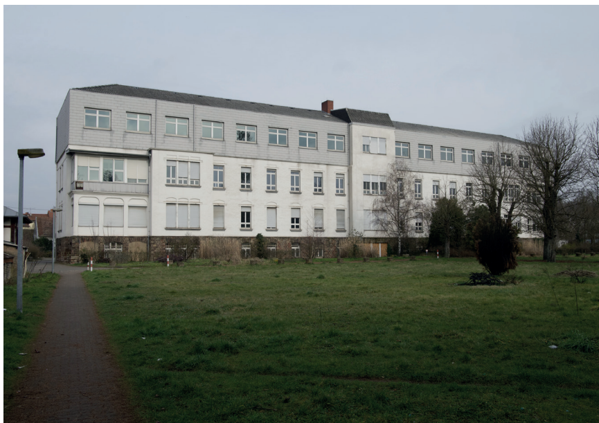
Blick auf das leer stehende Bestandsgebäude der ehem. SHG-Klinik aus Richtung Süden
