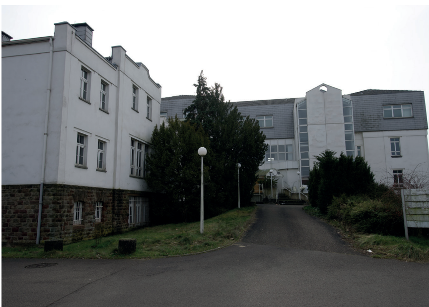
Blick auf das leer stehende Bestandsgebäude der ehem. SHG-Klinik aus Richtung Norden
