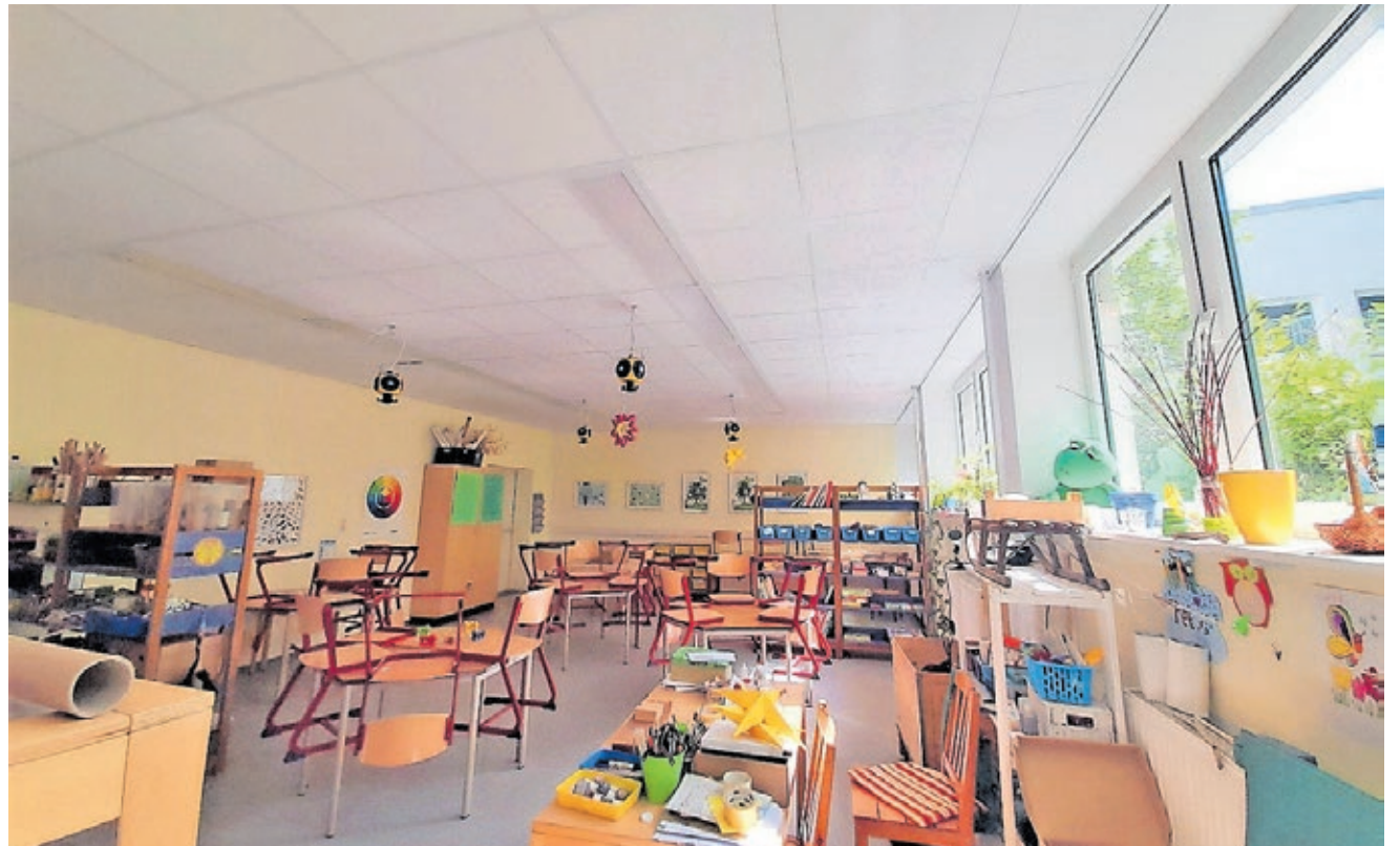
Eine moderne Schallschutzdecke ersetzt bereits die frühere Decke des Werkraums im Erdgeschoss der Grundschule Herrensohr-Jägersfreude.
