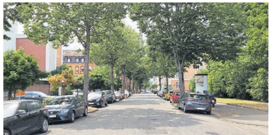
Die Fahrradstraße in der Hohenzollernstraße wird zurzeit in einem zweiten Bauabschnitt erweitert.
