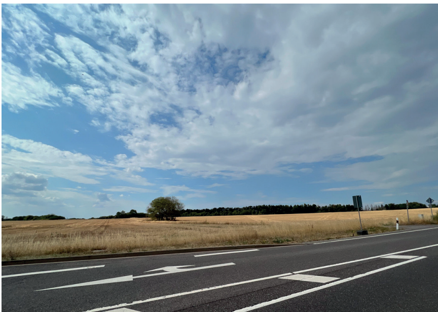
Blick in das Plangebiet aus südöstlicher Richtung (L 108 im Vordergrund)
